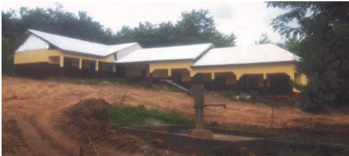
Das fertiggestellte Schulgebäude.
